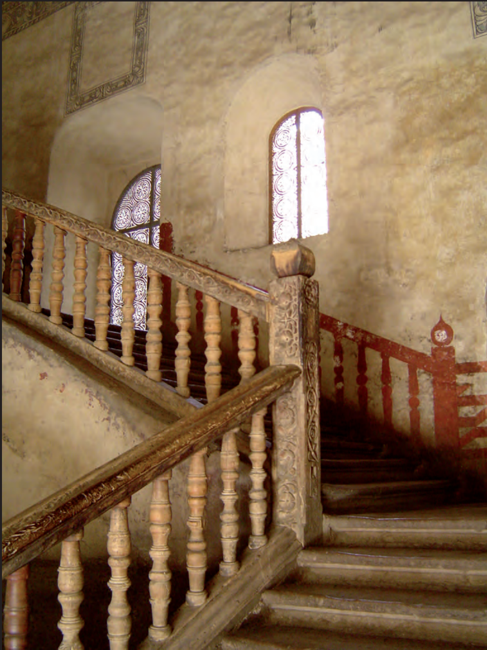
▲ Escalera del convento de Yuriria (fotografía: Eumelia Hernández)
