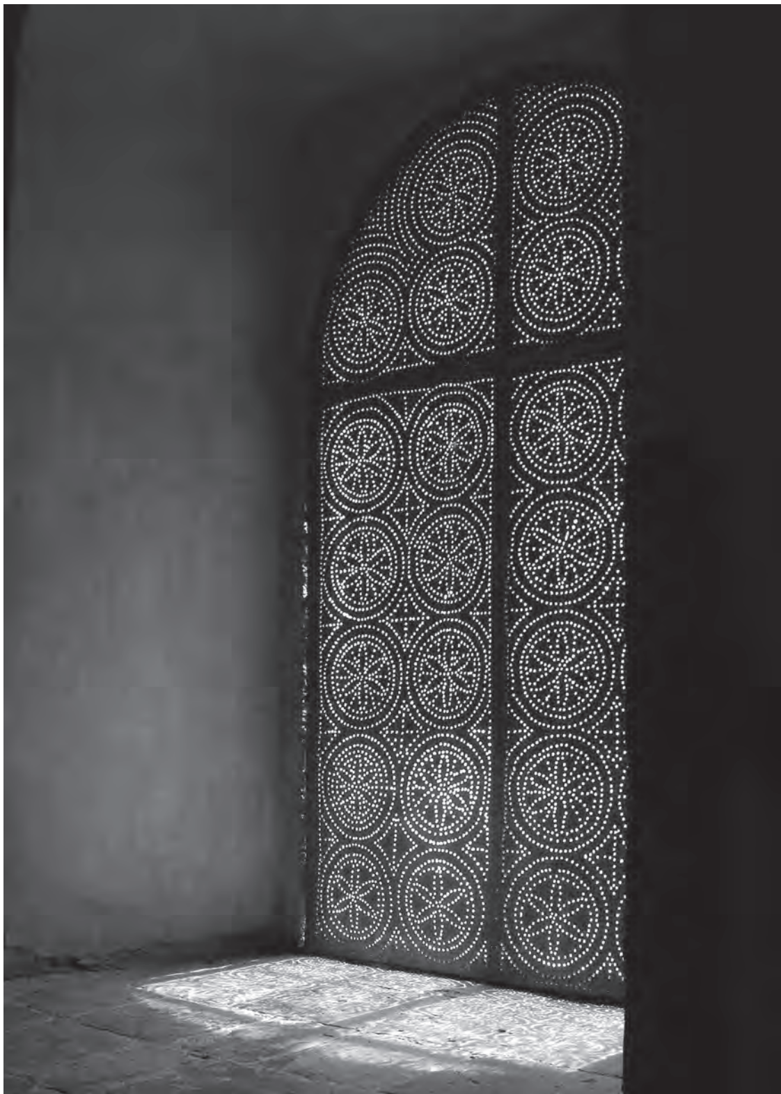
▲ Ventanas de lámina de hierro con decoración perforada en el cubo de la escalera (fotografía: Eumelia Hernández)
