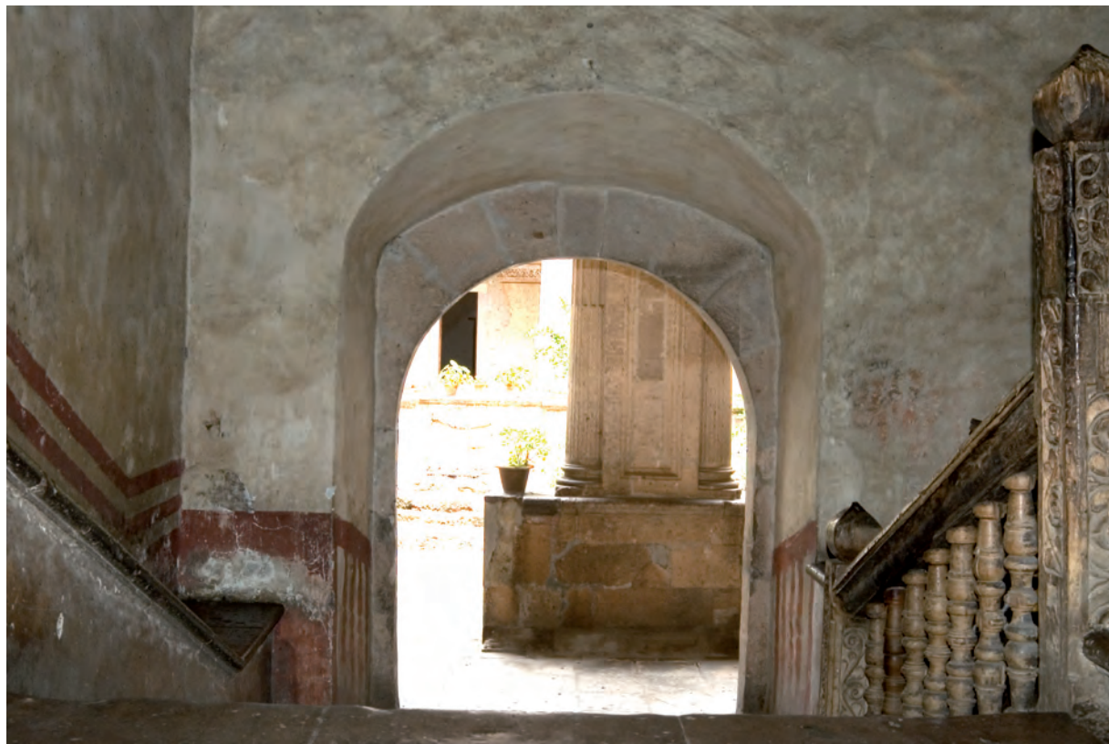
▲ Vano de dos vistas en el ex convento (fotografía: Eumelia Hernández)
