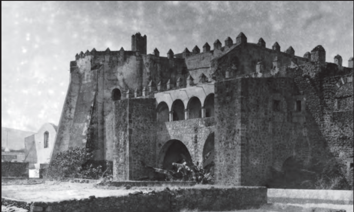
▲ Arquería de cuatro vanos con cubierta aparentemente plana, sobre la ligadura que une los contrafuertes (ca. 1910-1920) (fotografía: © 361846, SINAFO-Fototeca Nacional, INAH, Fondos coloniales)
