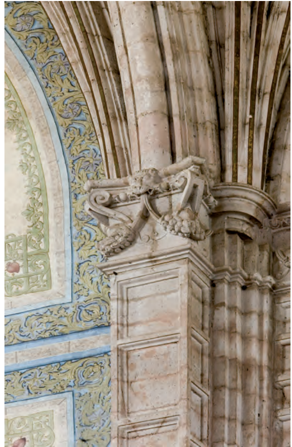
▲ Capitel con cabeza de león y volutas en forma de modillón en uno de los arranques de la bóveda del crucero del templo (fotografía: Eumelia Hernández)
