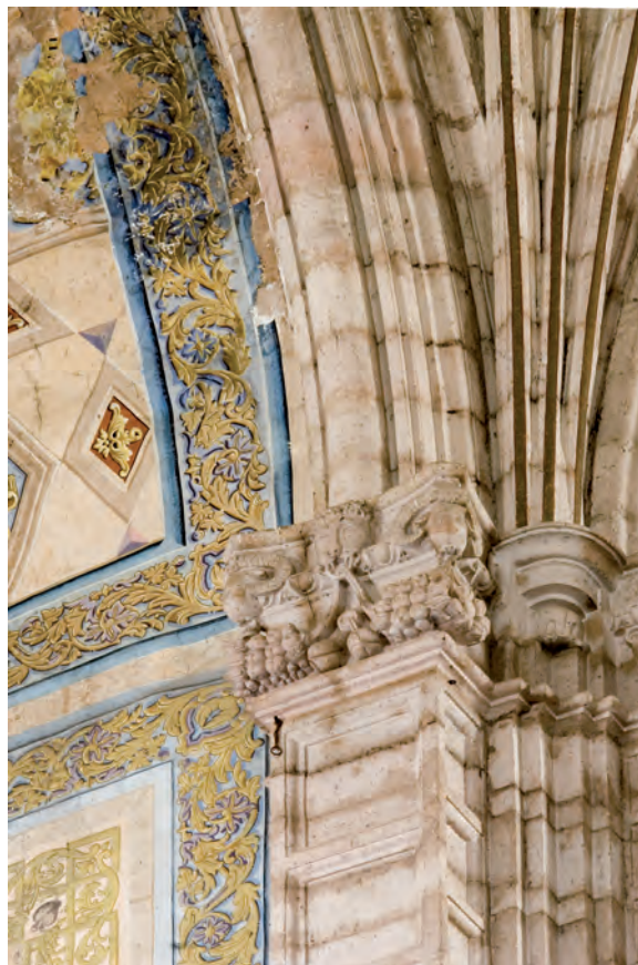
▲ Capitel con cabeza de león y bucráneos en uno de los arranques de la bóveda del crucero del templo (fotografía: Eumelia Hernández)
