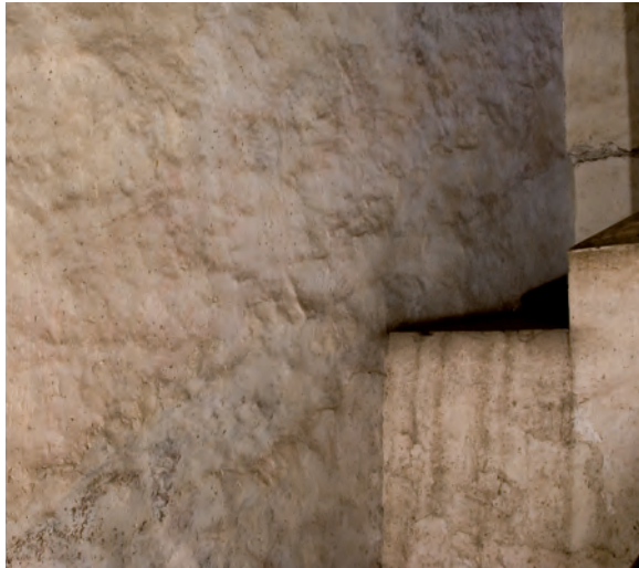
▲ Huellas de la escalera recta de un solo tramo (Fotografía: Eumelia Hernández)
