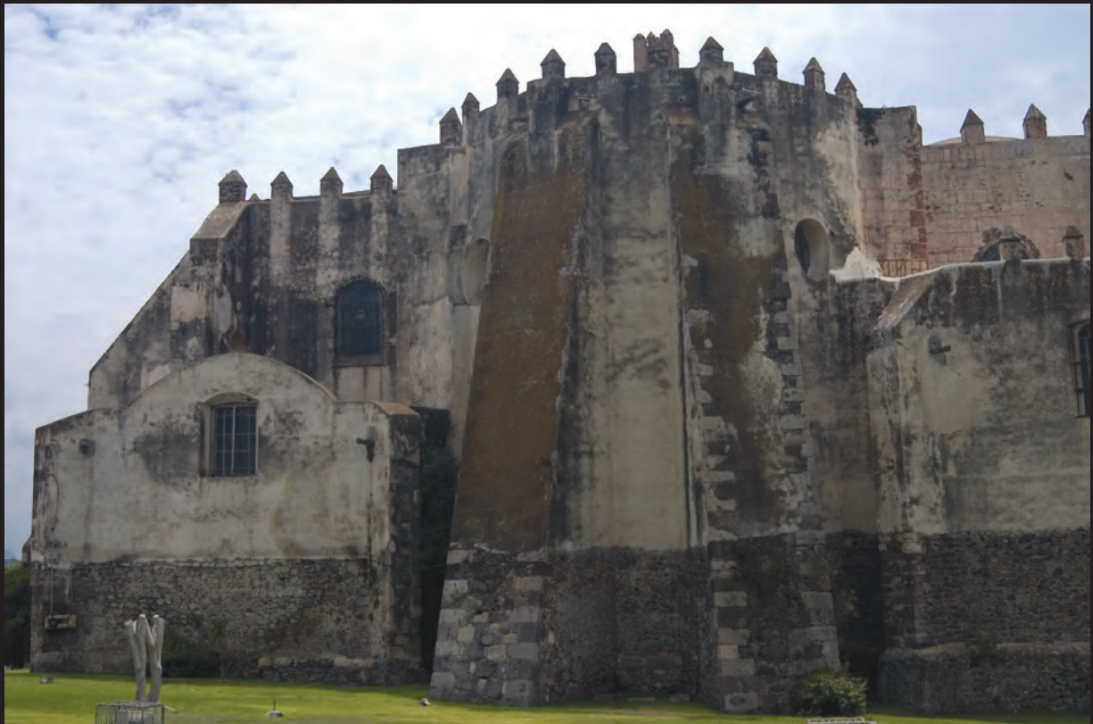
▲ Ojos de buey y de los contrafuertes que sostienen el ábside (fotografía: Eumelia Hernández)
