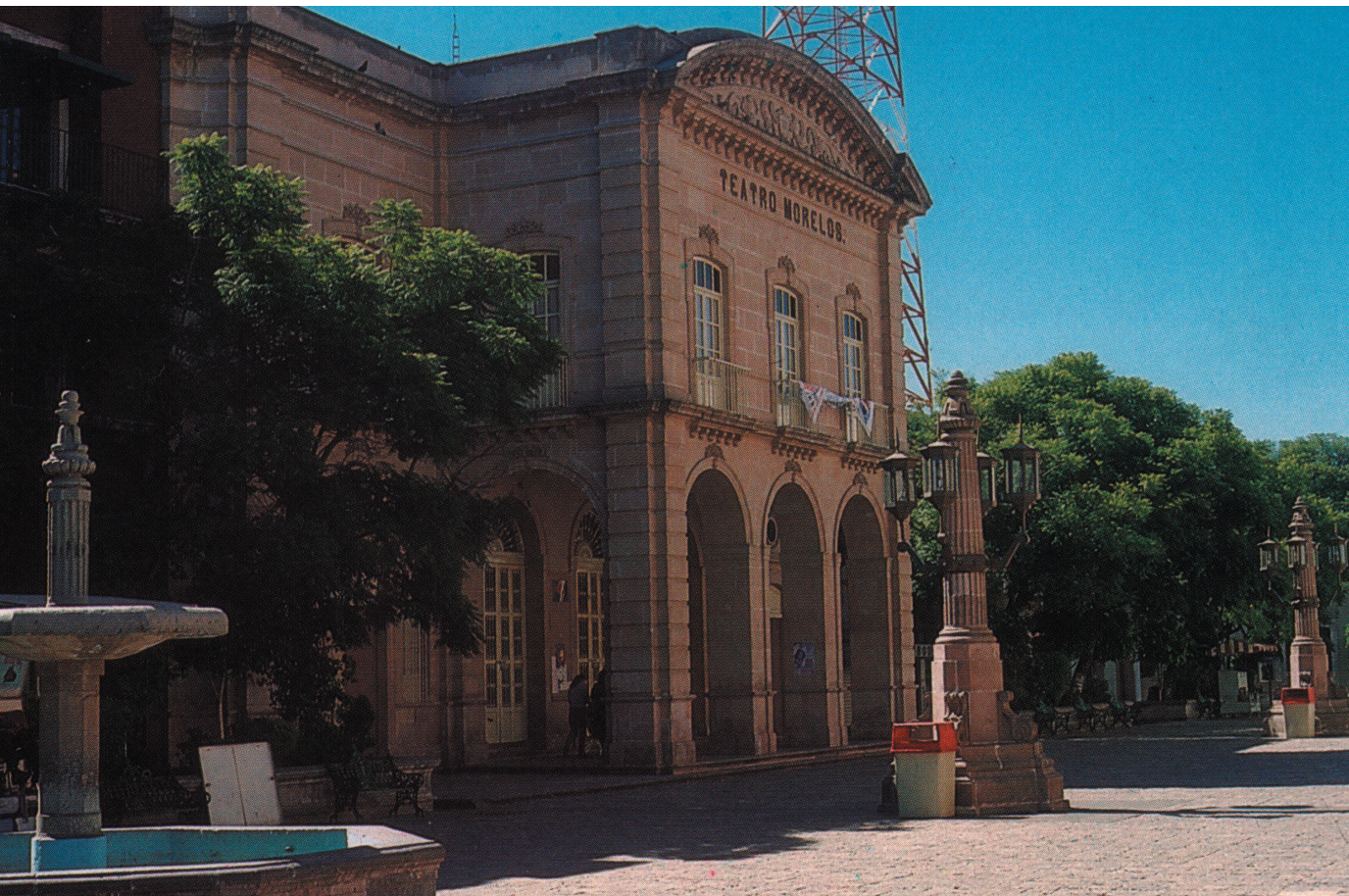
Aguascalientes. Teatro Morelos.
